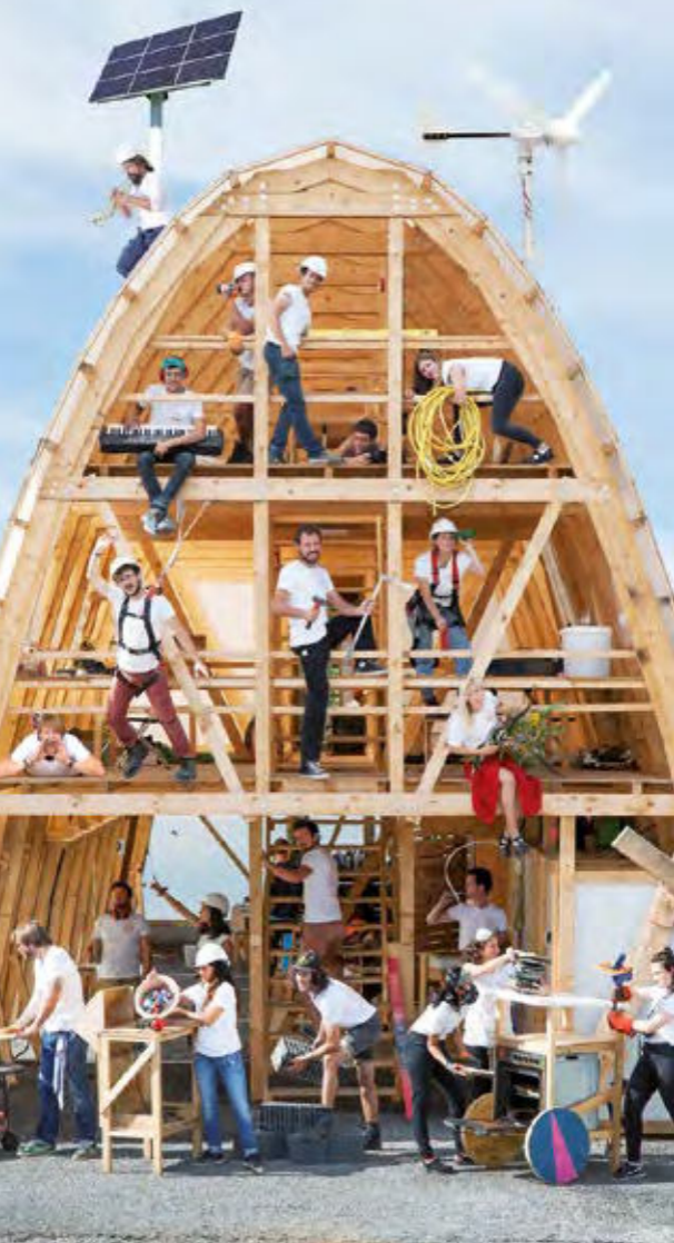
The Arch: Kollektive experimentelle Baustelle von constructlab in Thor Park, Genk, Belgien. Foto: Constructlab
