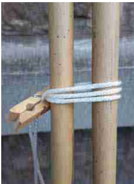
Beweglicher Knoten für die schrägen Stangen
