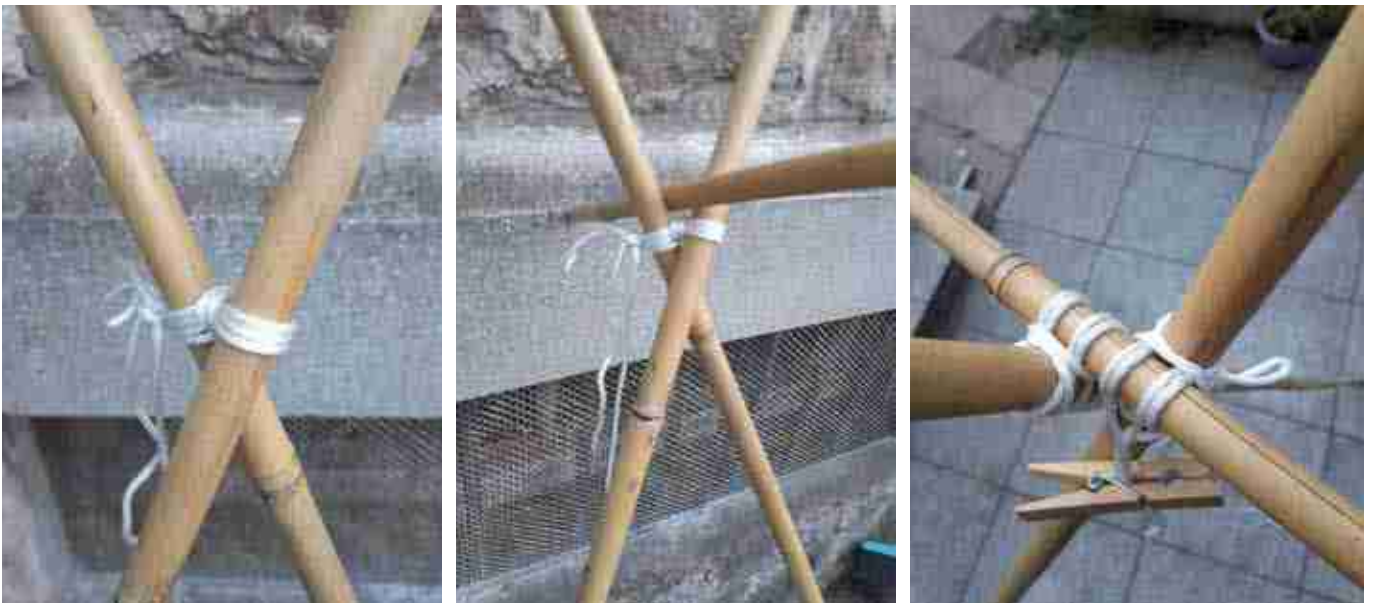
Auflegen und Verknoten der oberen Querstange
